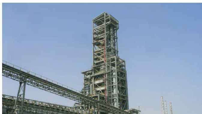
Qatar Steel Module 2
